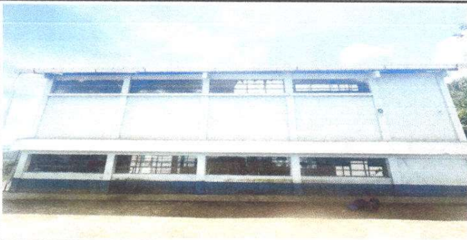
Foto 3: Sustitución de canal de pvc
