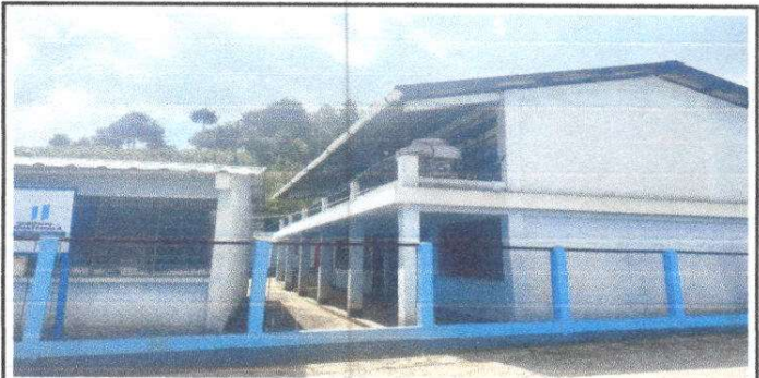
Foto 4: Sustitución de canal de pvc
