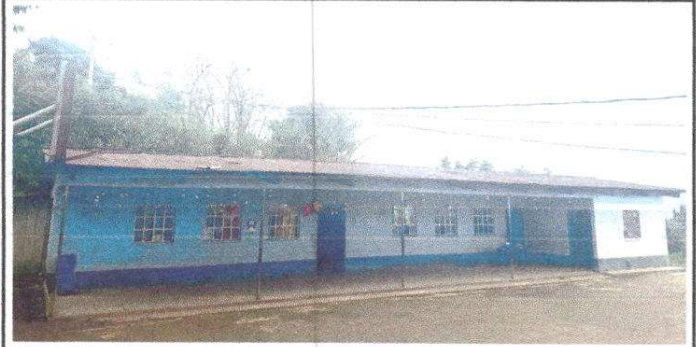
Foto 2: Sustitución de lámina, por lámina troquelada aluzinc calibre 26
