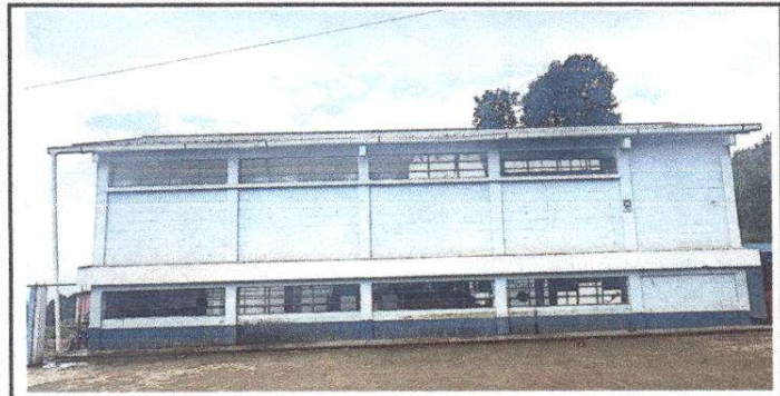
Foto 7: Pintura muros exteriores e interiores
